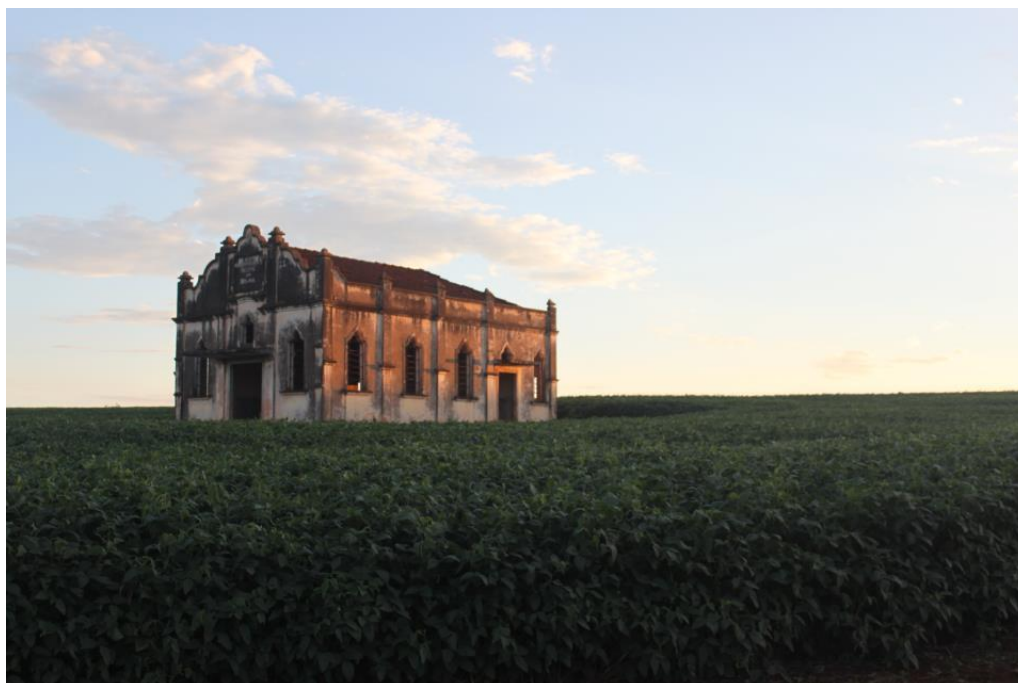
Figura 32 – Igreja abandonada em Jataizinho - Pr.
